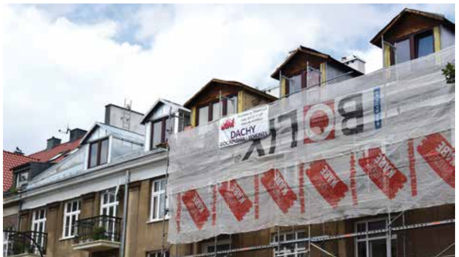
▲ Dachpol ma swoje rusztowania i wciągarki, dlatego do wysokości 3–4 pięter nie potrzebuje dodatkowego sprzętu; na zdjęciu lukarny od ulicy w trakcie ocieplania
