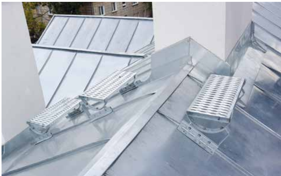
▲ Stopnie kominiarskie na dachu z taką ilością kominów są niezbędne
