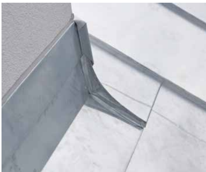
▲ Szczegół obróbki blacharskiej
