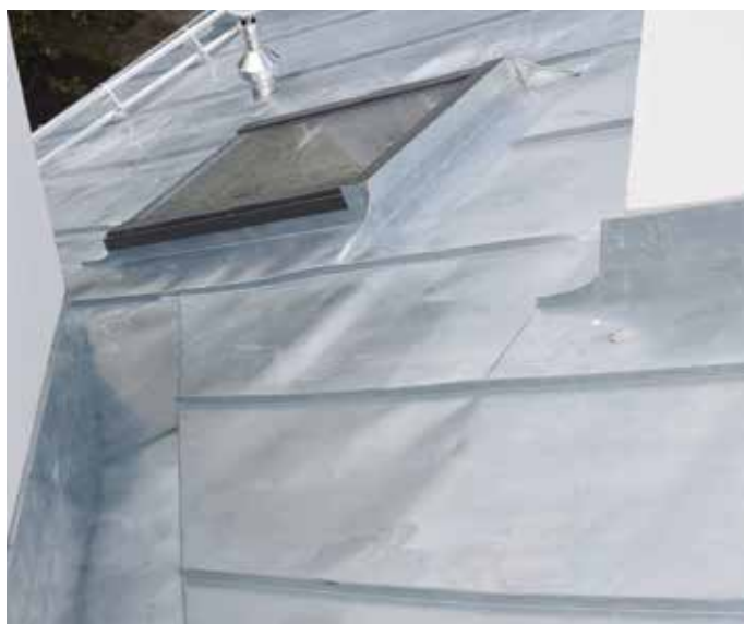
▲ Do obróbki były również wytazy i kominki ze stali kwasoodpornej
