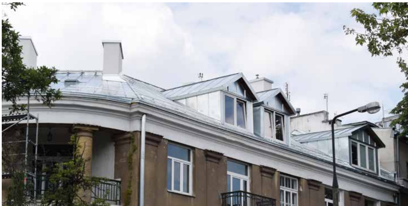
▲ Dach już gotowy, teraz czas na elewację?
