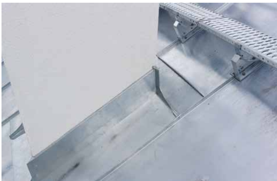
▲ Szczegóły obróbki kominia z widoczną łąwą dachową
